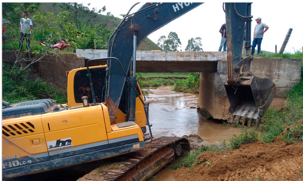
PONTE DE SÃO CRISTÓVÃO – EQUIPE DA SECRETARIA MUNICIPAL DE OBRAS DE RIO PRETO-MG
